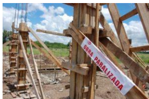
Obra interrompida em Córrego das Chuvas
